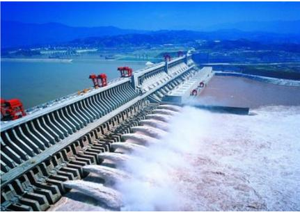
【三峽大壩】即長江三峽水利樞紐工程，又稱三峽工程。中國湖北省宜昌市境內的長江西陵峽段與下游的葛洲壩水電站構成梯級電站。三峽水電站是世界上規模最大的水電站，也是中國有史以來建設最大型的工程項目。而由它所引發的移民搬遷、環境等諸多問題，使它從開始籌建的那一刻起，便始終與巨大的爭議相伴。三峽水電站的功能有十多種，航運、發電、種植等等。三峽水電站 1992 年獲得中國全國人民代表大會批准建設，1994 年正式動工興建，2003 年六月一日下午開始蓄水發電，於 2009 年全部完工。三峽水電站大壩高程 185 米，蓄水高程 175 米，水庫長 2335 米，總投資 954.6 億元人民幣，安裝 32 台單機容量為 70 萬千瓦的水電機組。三峽電站最後一台水電機組，2012 年 7 月 4 日投產，這意味著，裝機容量達到 2240 萬千瓦的三峽水電站，2012 年 7 月 4 日已成為全世界最大的水力發電站和清潔能源生產基地。
